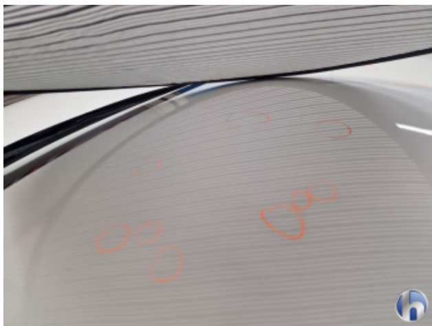
4. Dach Hagelschaden - Instandsetzen
