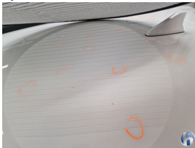
4. Dach Hagelschaden - Instandsetzen
