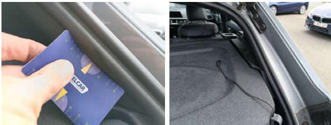
Koffer - Afdichtingsrubber koffer - Scheur - Vervangen
