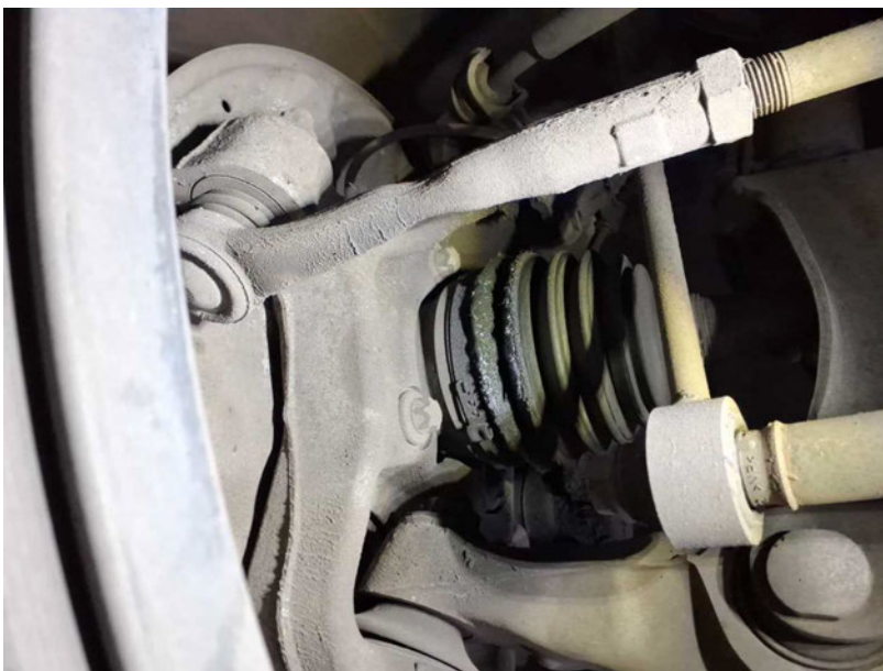
Beschädigung #17: Antriebsstrang: Manschette Gelenkwelle vorn rechts (aussen) - gebrochen / gerissen - erneuern
