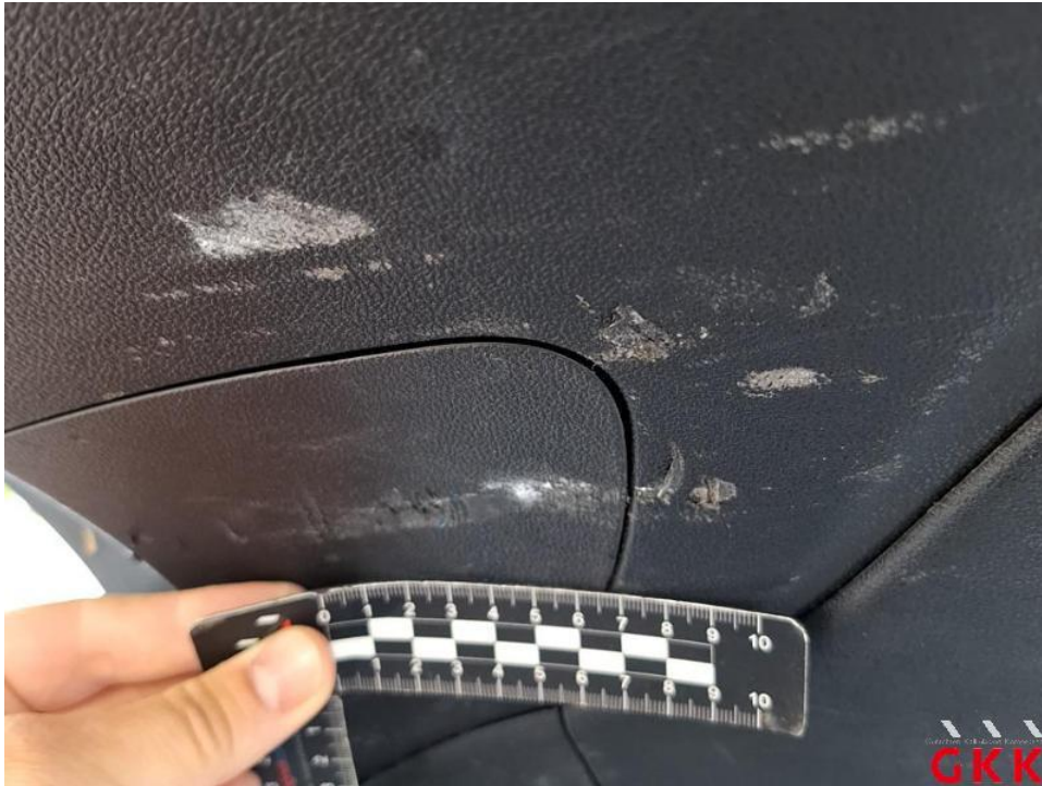
Bild 35. Heckklappe, Innenverkleidung, verkratzt, ersetzen
