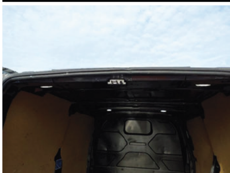
Joint d'entrée de porte / Arrière / Déchiré
