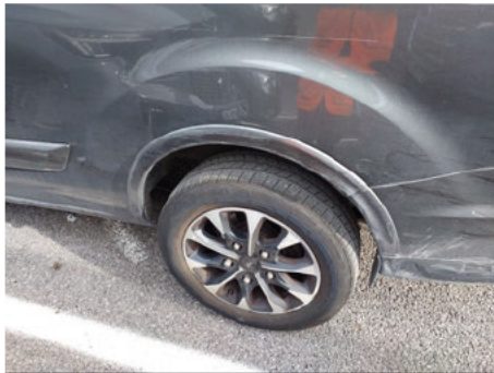
Extension d'aile / Arrière Gauche / Cassé
