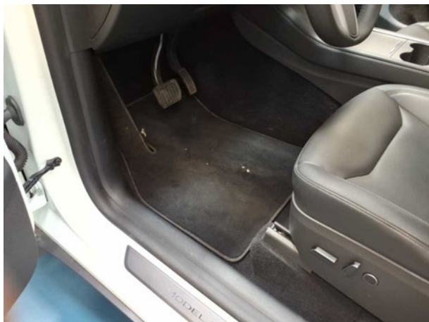
Beschädigung #1: Verkleidungen/Abdeckungen: Fußmatten - beschädigt - erneuern
