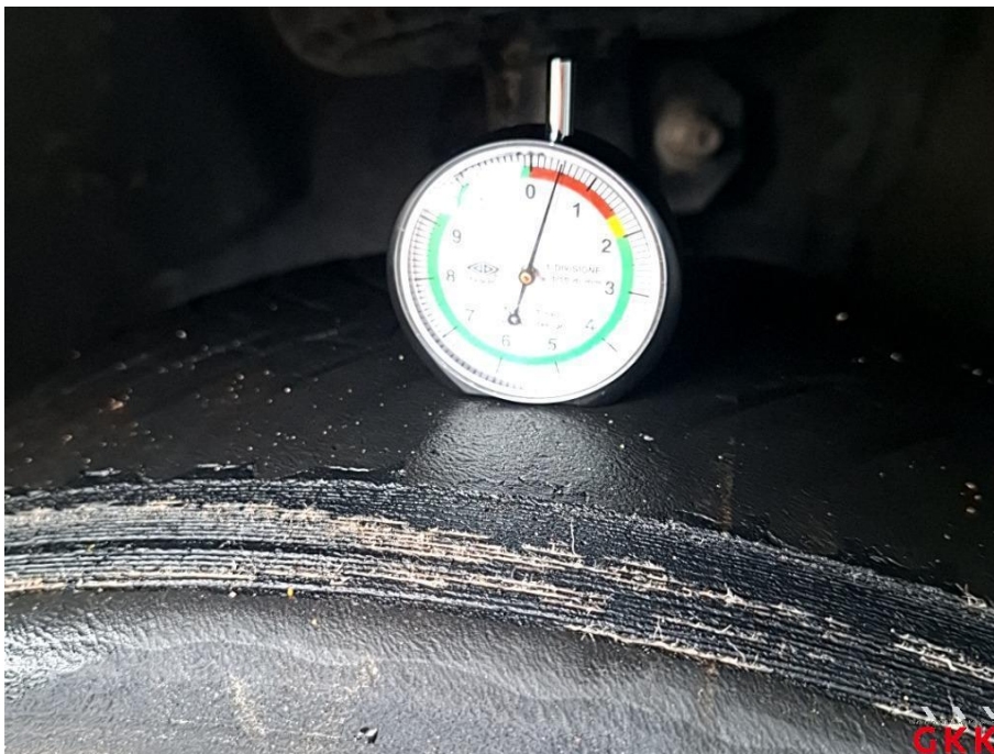
Bild 14 Reifen, vorn links und rechts, Untermaß, ersetzen
