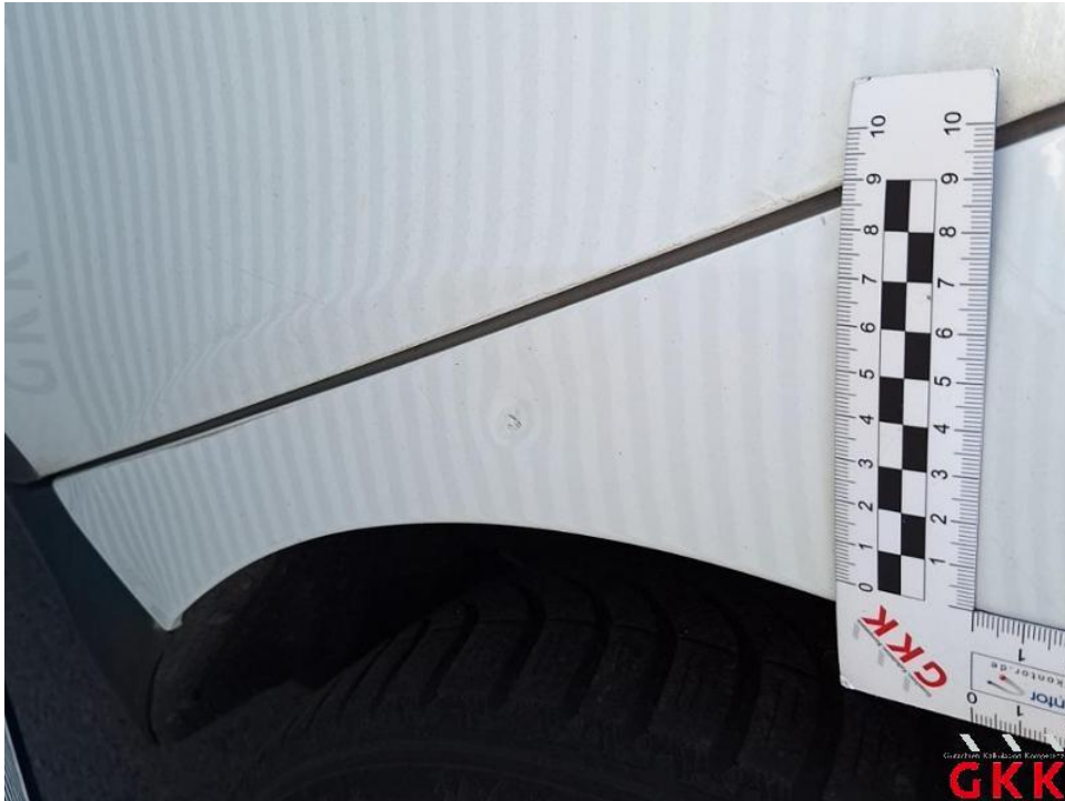
Bild 27. Seitenwand links, beschädigt, instand setzen - lackieren
