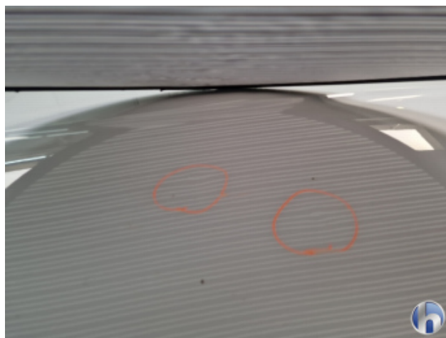
6. Dach Dellen / Beulen - Sanft Instandsetzen
