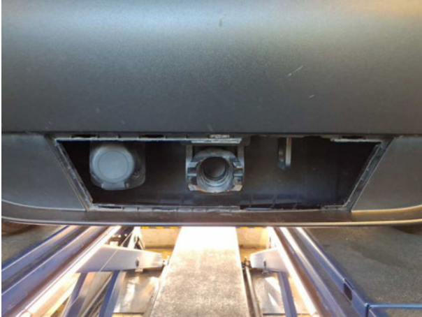
Beschädigung #1: Stossfänger hinten: Abdeckung Stossfänger hinten (AHK) - fehlt - erneuern
