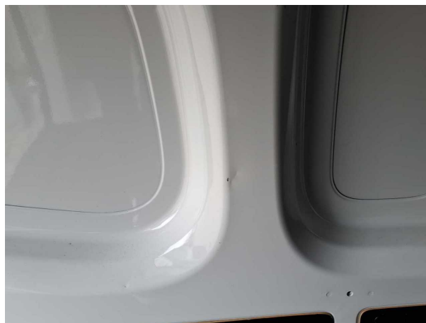
Beschädigung #3: Interieur: Laderaumboden - Delle / Lackschaden - Wertminderung
