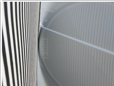
Seitenwand / Hinten Links / Delle
