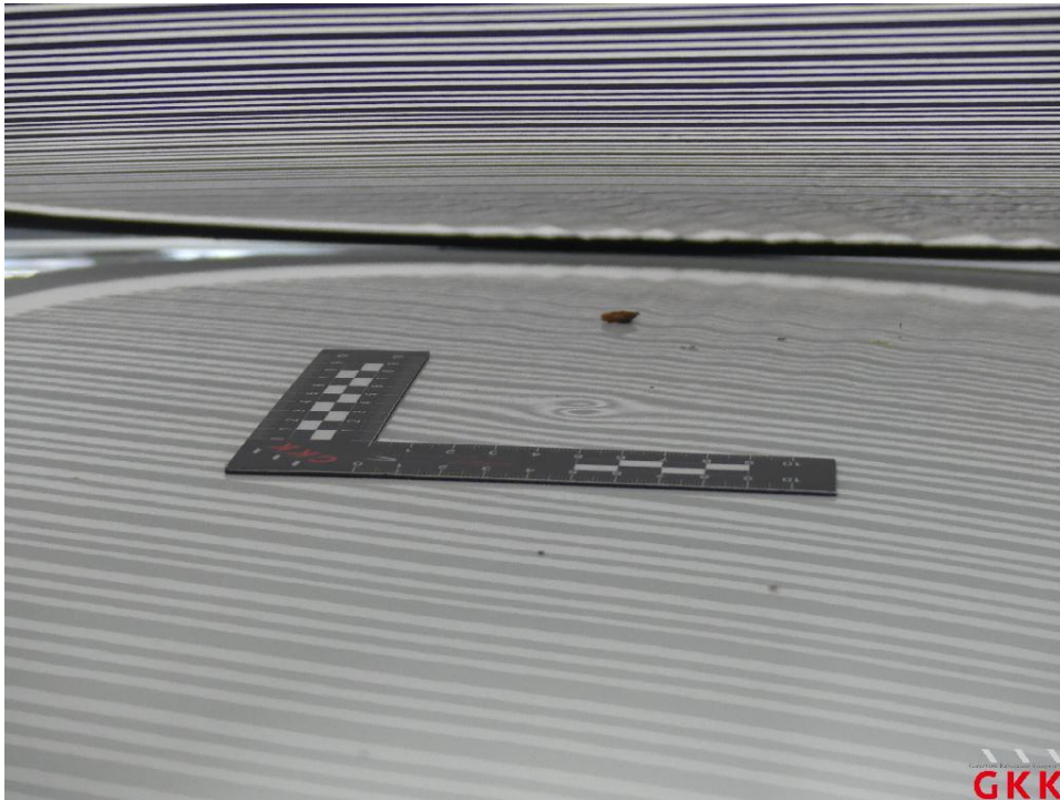
Bild 19 Dach, beschädigt, kalt drücken
