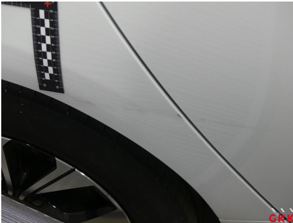
Bild 24 Seitenwand rechts, beschädigt, instand setzen - lackieren
