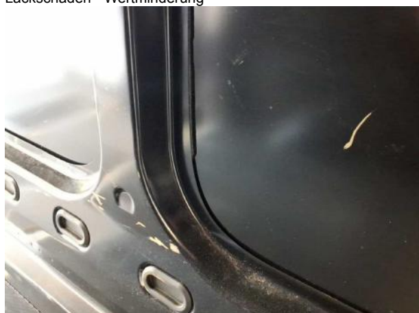
Beschädigung #8: Interieur: Laderaumunterteilung - Delle / Lackschaden - Wertminderung
