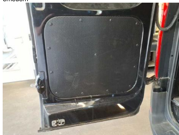
Beschädigung #8: Interieur: Laderaumunterteilung - Delle / Lackschaden - Wertminderung
