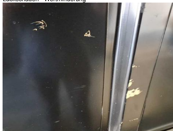
Beschädigung #8: Interieur: Laderaumunterteilung - Delle / Lackschaden - Wertminderung
