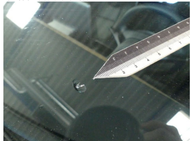
Beschädigung #6: Verglasung: Frontscheibe - Steinschlag - erneuern
