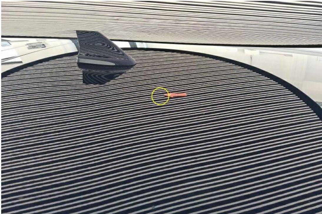
Bild 17 : Dach, mehrfach eingedellt, drücken
