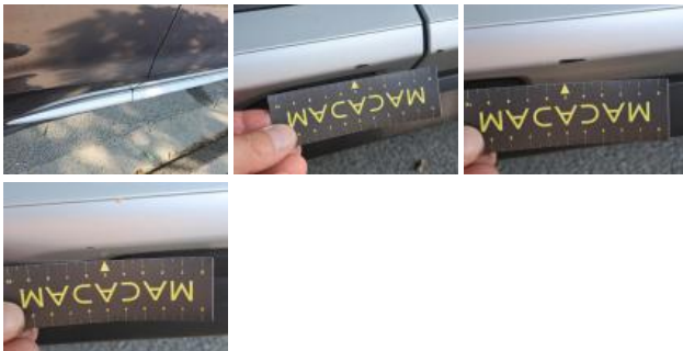
Door trim FR, Scratch(es), Replace
