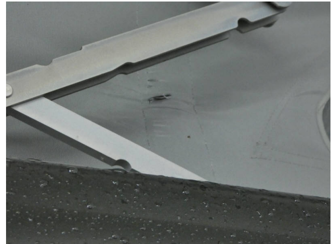
Aufstelldach Gerissen - Smart Repair
