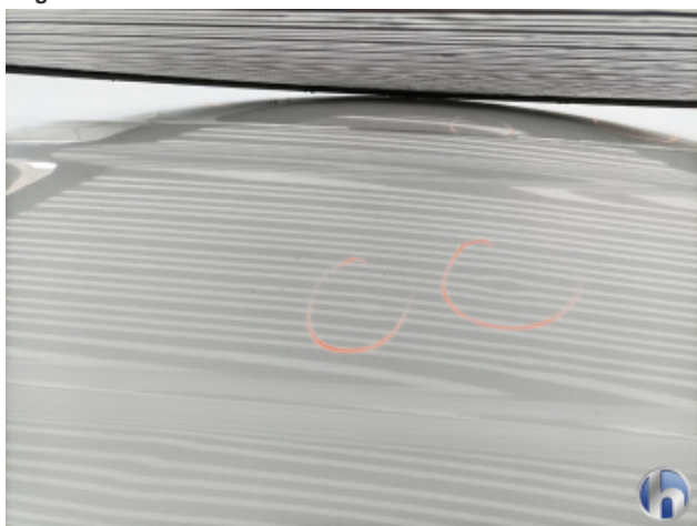
1. Dach Hagelschaden - Sanft Instandsetzen
