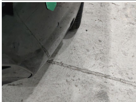
Stoßfänger / Hinten / Schlecht Repariert
