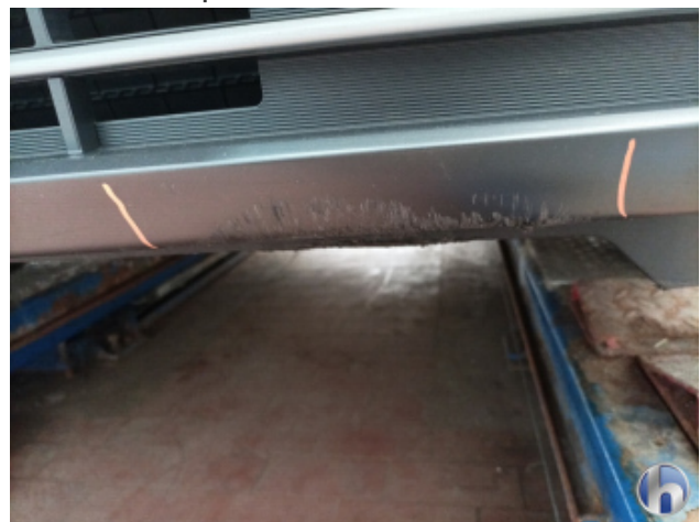
3. Frontspoiler Beschädigt - Erneuern
