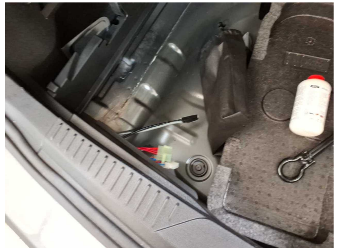
Damage 1: Electrical system: Cable strand (Kabelführung für Frontbereich im Laderaum) - Specify findings - Remove
