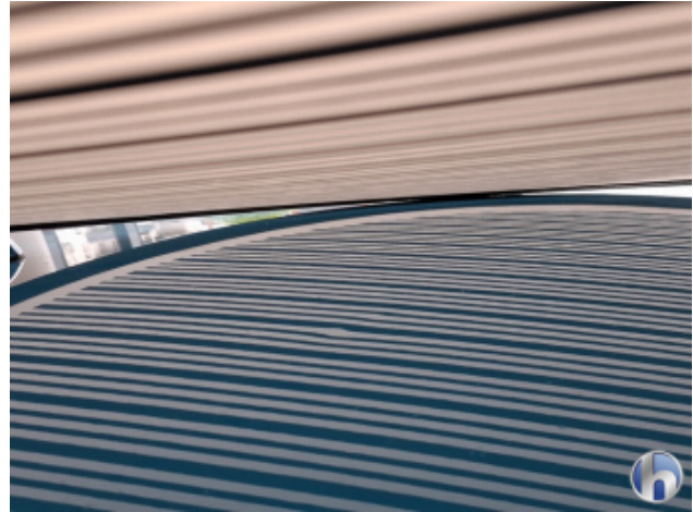
1. Dach 2 Dellen - Sanft Instandsetzen
