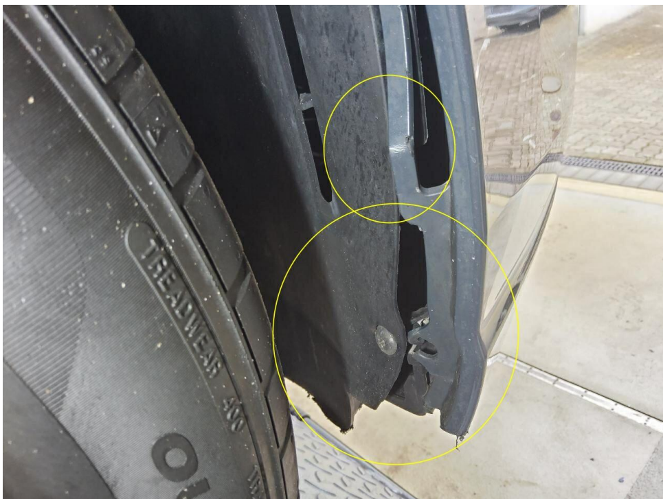
Bild 18 : Stoßfänger vorne verformt und verschrammt.
