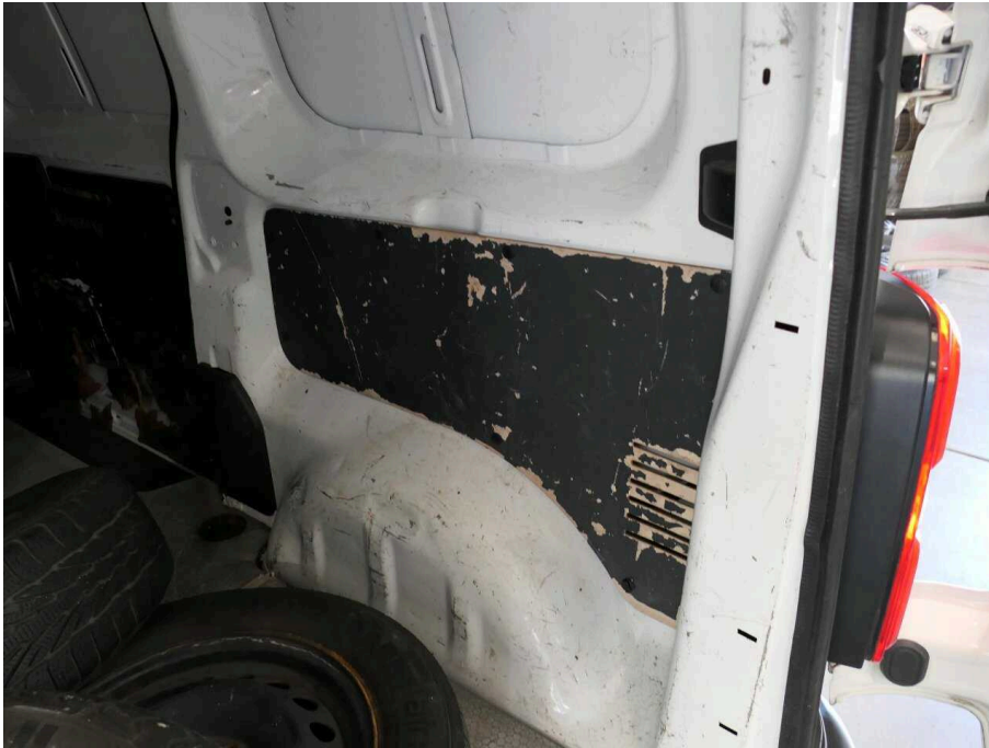
Bild 27 Innenraum Laderaumverkleidung rechts alle mit Schiebetürverkleidung gebrochen
