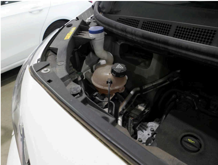
Bild 45 Wartung / Prüfung Kühlmittel zu niedrig
