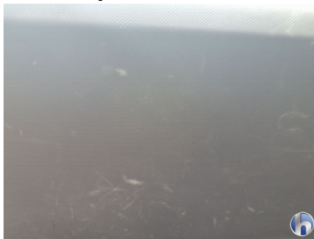
13. Verkleidung Verschmutzt - Reinigen
