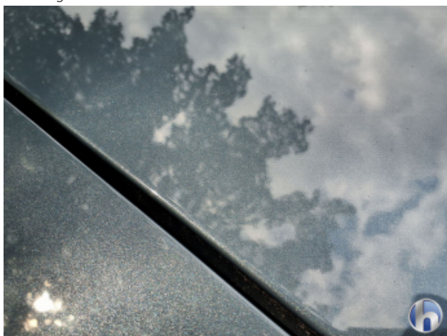
1. Dach Verdellt - Sanft Instandsetzen
