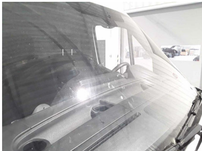
Gebrauchsspur 3: Verglasung: Frontscheibe - Steinschlag - kein Abzug
