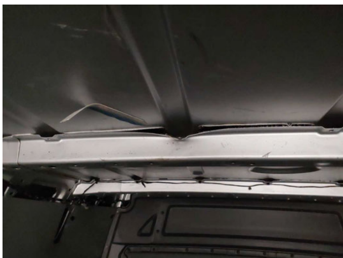
Beschädigung 47: Fahrzeugdach: Dach - verformt - kein Abzug
