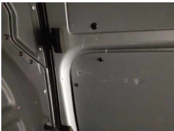
Beschädigung 44: Schiebetür rechts: Verkleidung Standard oben - Löcher - kein Abzug
