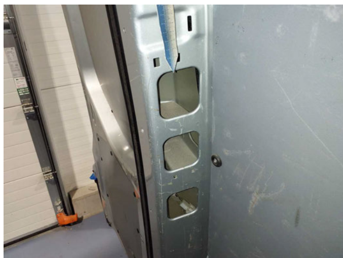
Beschädigung 40: Verkleidungen/Abdeckungen: Verkleidungen/ Abdeckungen - fehlt - kein Abzug
