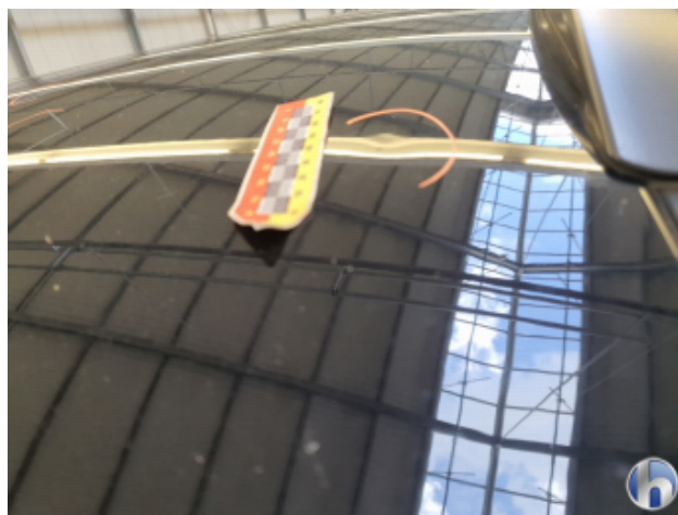
5. Dach 3 Dellen - Sanft Instandsetzen
