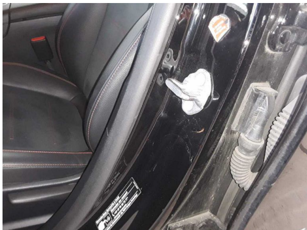
Beschädigung #1: Schweller links: Einstieg - Delle(n) - Smart Repair
