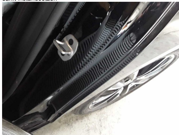
Beschädigung #5: Seitenwand links: Einstieg - Delle(n) - Smart Repair
