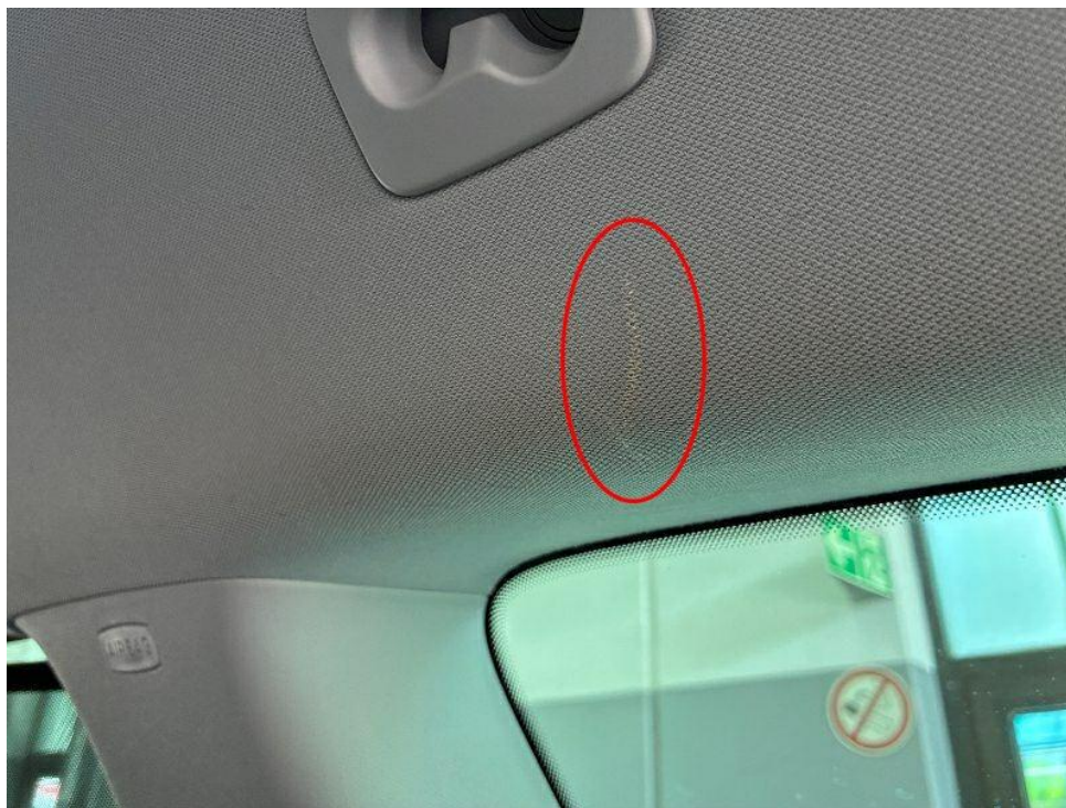
Bild 38 : Dachhimmel, zerkratzt, Gebrauchsspur
