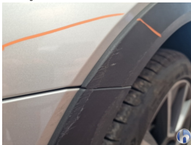
5. Radausschnitt Abdeckungen Beschädigt - Erneuern
