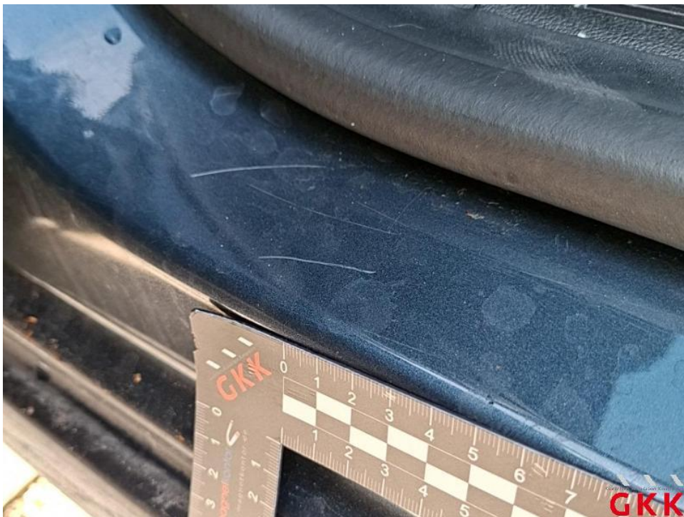
Bild 60. Tür vorne links, Einstieg, verkratzt, Smartrepair
