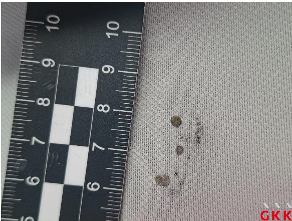
Bild 30. Himmel, Brandloch, ersetzen
