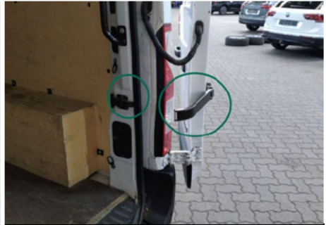
Türfangband / Hinten Links / Defekt
