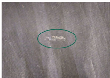
Holzboden / Hinten / Gebrochen
