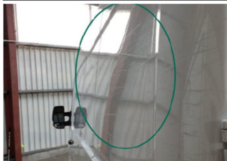
Seitenwand / Hinten Links / Delle
