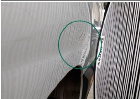
Seitenwand / Hinten Links / Delle
