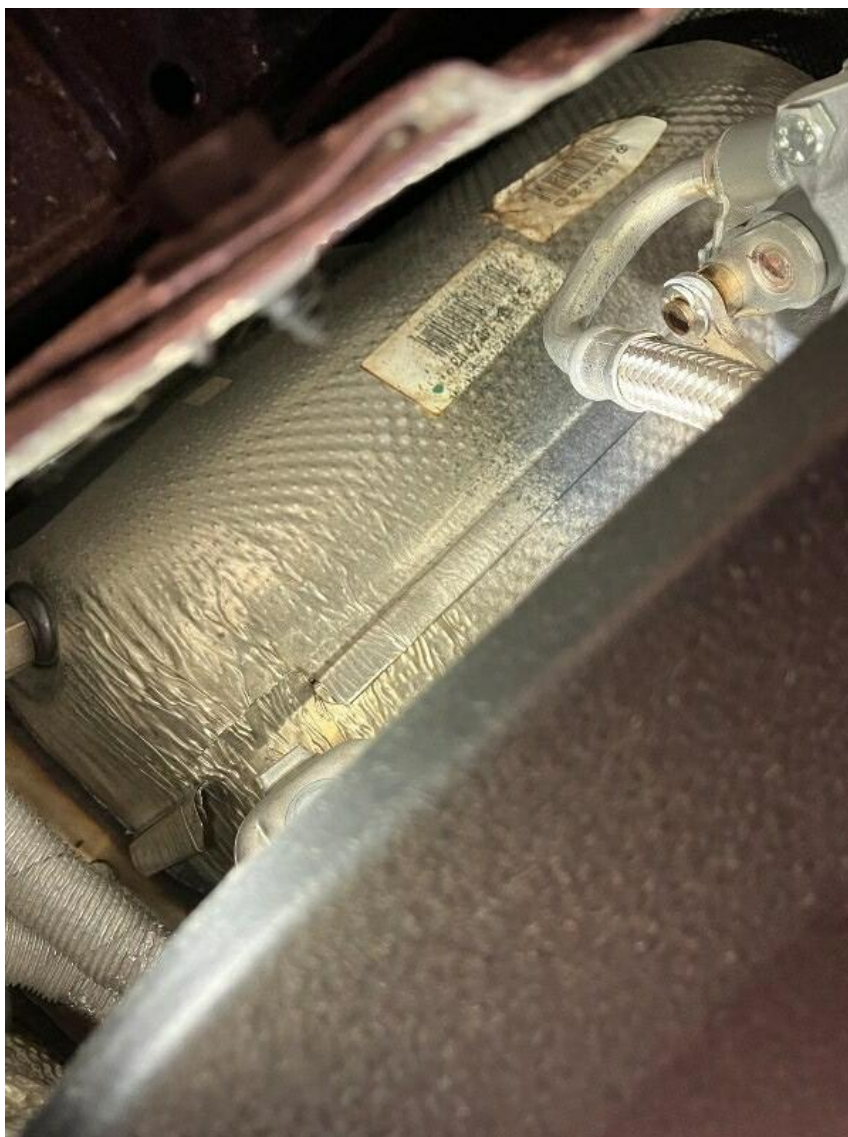
Bild 16 : Abgasanlage im Bereich Turbolader verrust
