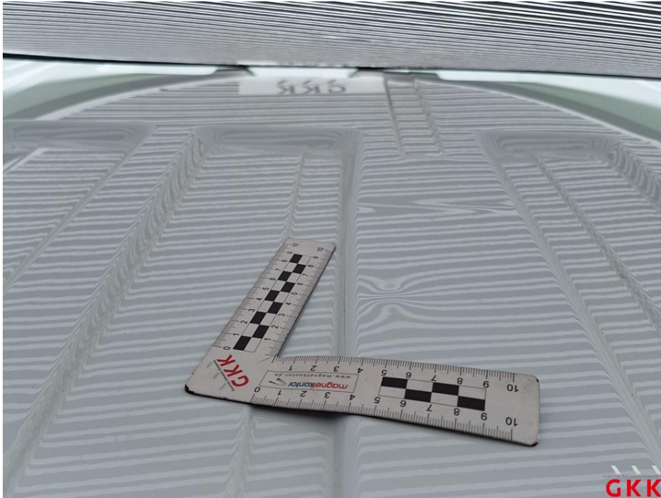
Bild 41. Dach, beschädigt, instand setzen - lackieren
