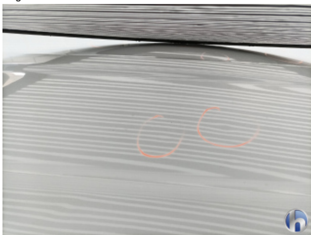
1. Dach Hagelschaden - Sanft Instandsetzen
