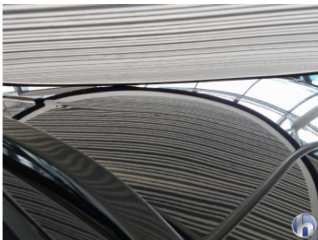
1. Dach Gebrauchsspuren - Ohne Reparatur
