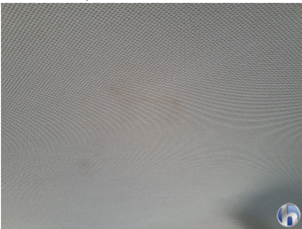
10. Dachhimmel Verschmutzt - Reinigen
