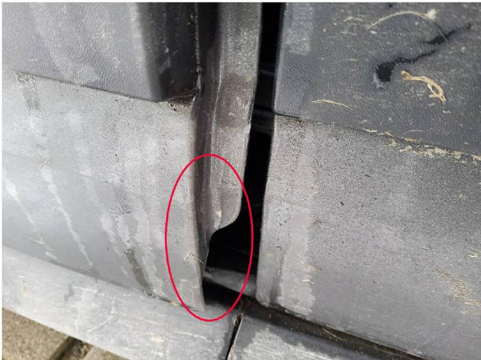
Bild 6 : Türe hinten rechts
