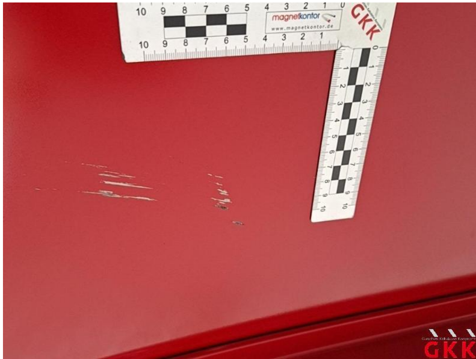
Bild 25. Heckklappe, innen, beschädigt, instand setzen - lackieren
