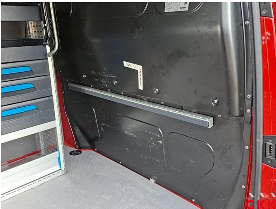
Bild 12. Trennwand, verkratzt, Spotlackieren
