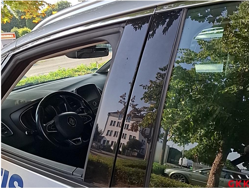
Bild 23. Tür vorne links, Blende -Fensterrahmen-, verkratzt, ersetzen
