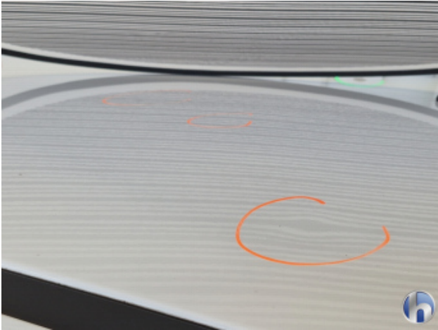
4. Dach Dellen / Beulen - Sanft Instandsetzen
