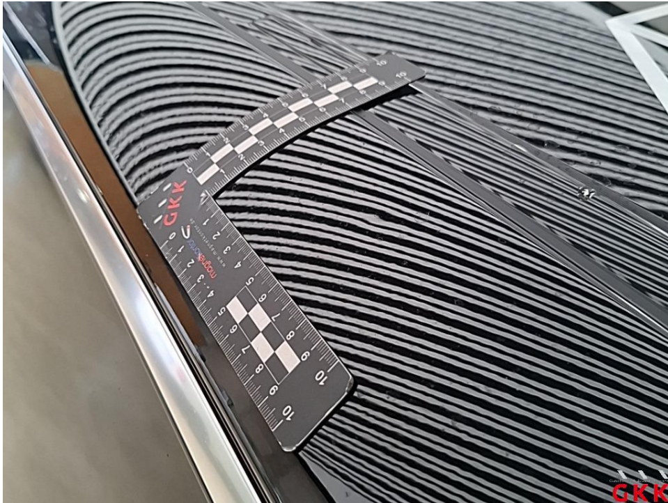
Bild 27. Dach, Holm links, beschädigt, Smartrepair
