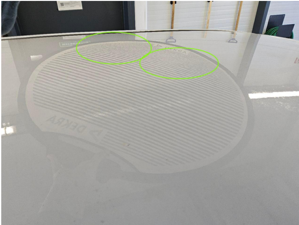
Bild 13 : Dach, Restspuren aus Instandsetzung, noch Dellen vorhanden
