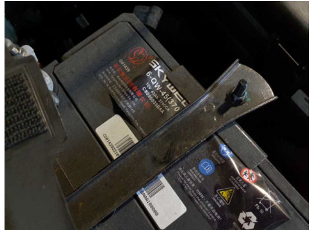
Beschädigung #4: elektrisches System: Batterie - elektrischer Fehler - befunden ggf. instandsetzen
