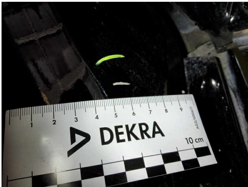
Bild 23 : Einstiegsschweller vorne rechts Kratzer bis Grundierung
