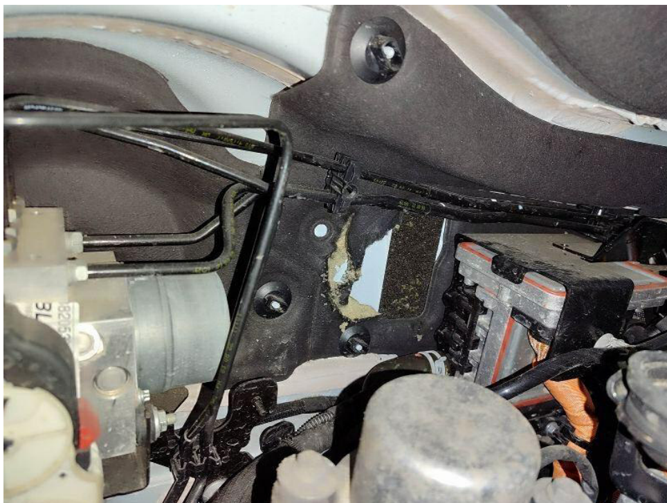
Bild 15 : Motorraumabdeckung ist gerissen
