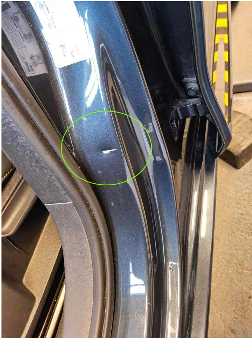
Bild 31 : Einstieg vorne links verschrammt
